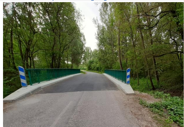
Ouvrage après travaux
