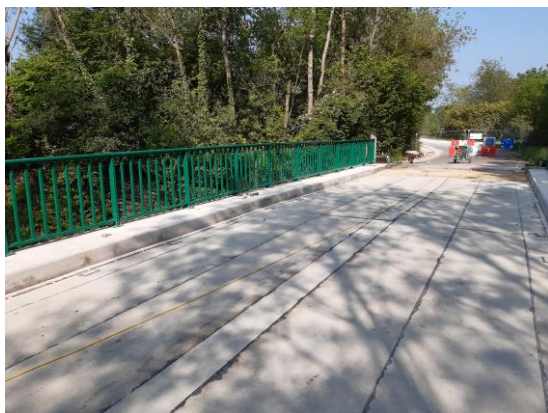
Réalisation de l'étanchéité
