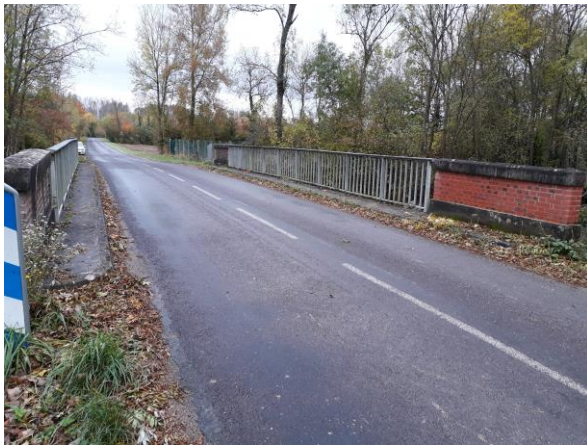
Ouvrage avant travaux
