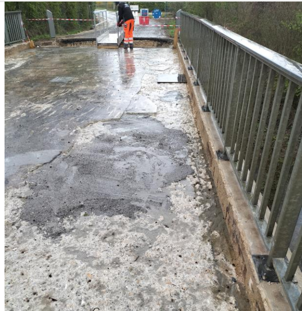
Préparation et ragréage du tablier
