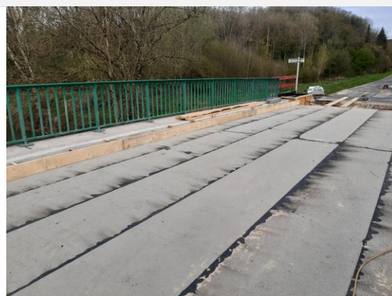
Création de l'étanchéité
