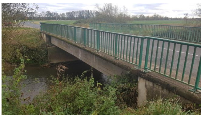
Ouvrage avant travaux
