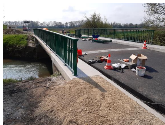
Ouvrage après travaux
