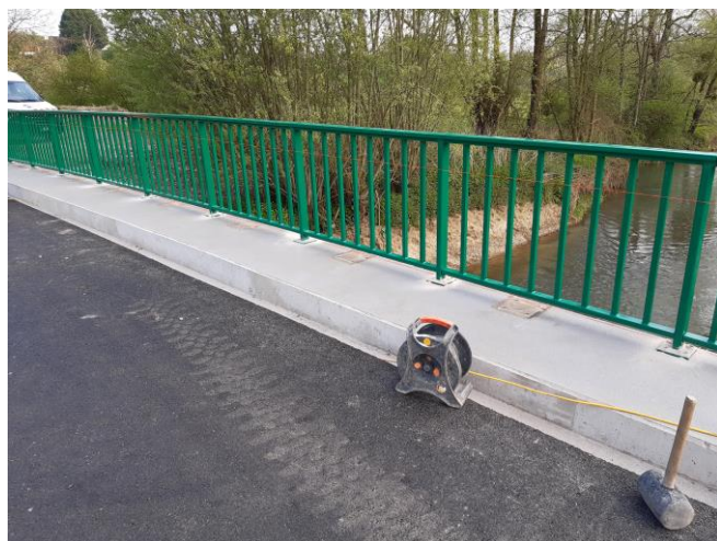
Pose des garde-corps
