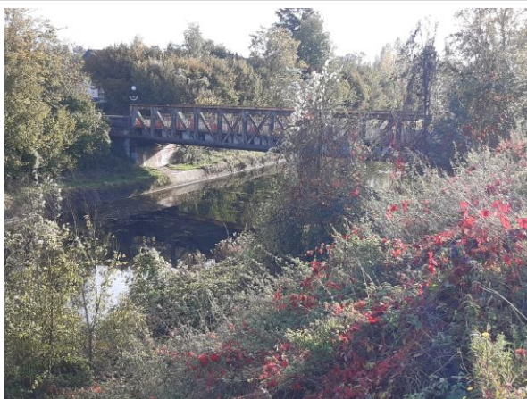
Ouvrage avant travaux
