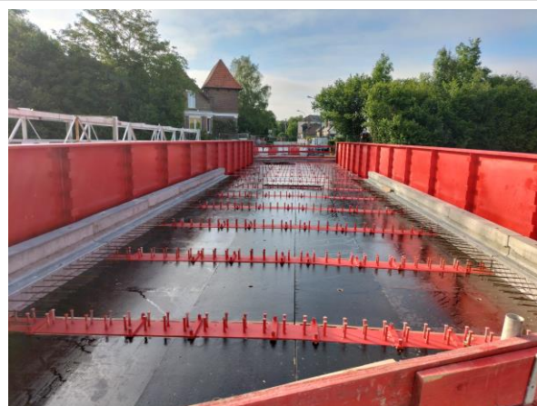
Pose de la nouvelle charpente
