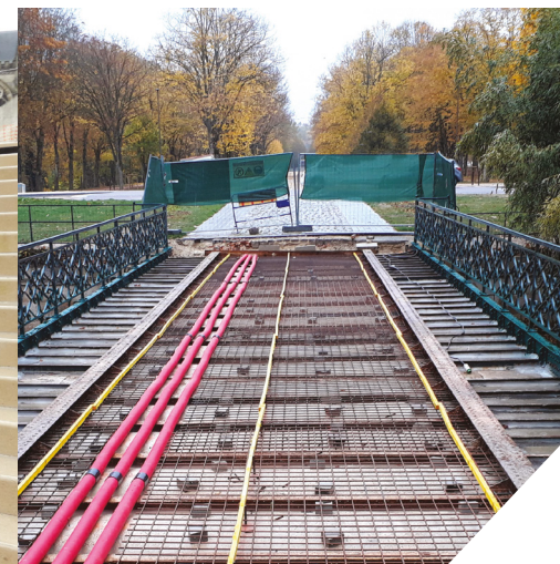
Reconstruction hourdis béton CHALONS-EN-CHAMPAGNE (51)
